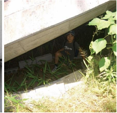
⑫ 構造物の下の空間に潜り込む
